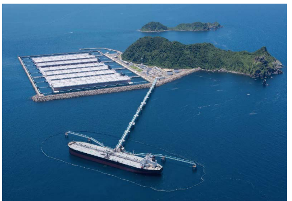
白島国家石油備蓄基地
